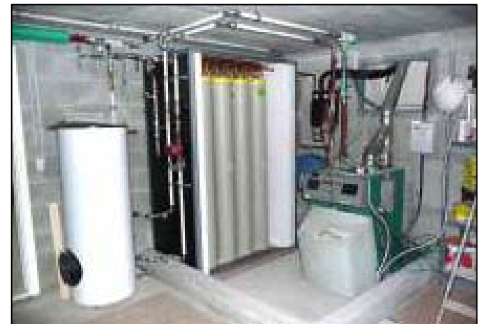
Latentwärmезellensystem der Powertank GmbH (Quelle: Datenblatt Powertank GmbH, Sonneberg)
